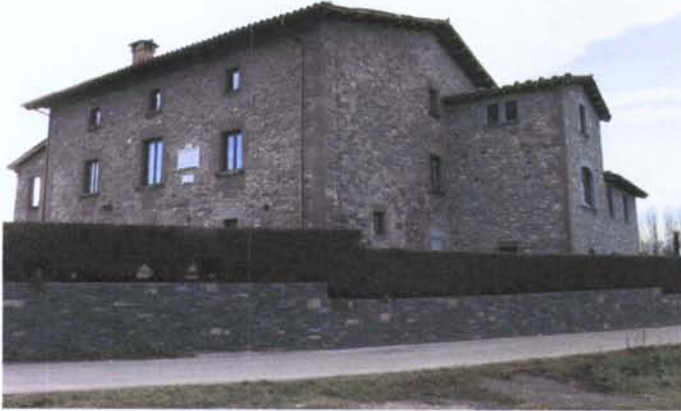
VISTA DE LA PART MÉS ANTIGA DEL MAS CONSERVADA AMB UN COS ANNEX AL NORD PROBABLEMENT CONTEMPORANI.
