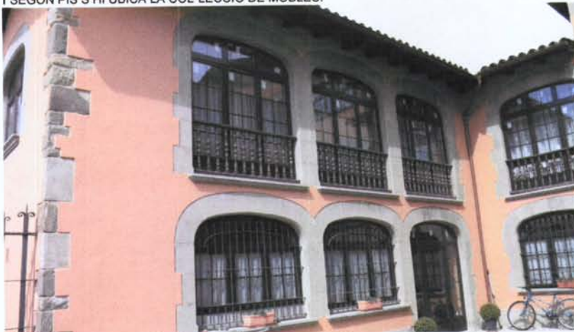
FAÇANA EST DEL COS (3). GALERIA D'ARCS REBAIXATS
