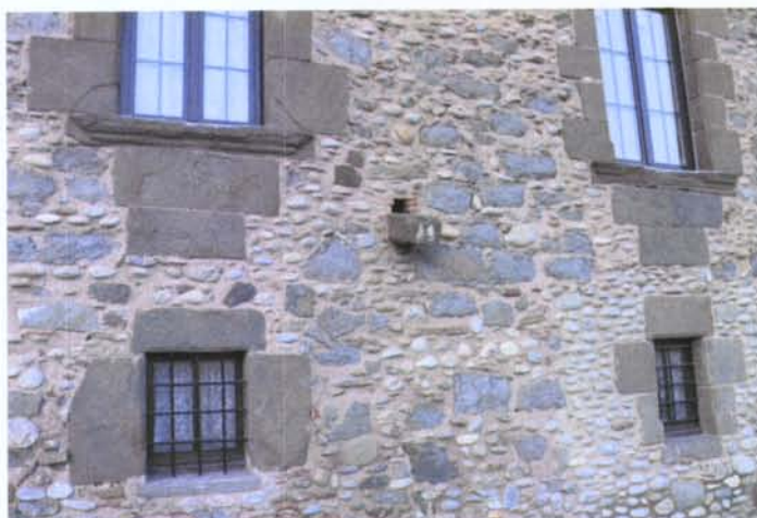
DETALL D'UNA GÀRGOLA EN EL PARAMENT. FAÇANA EST COS (1)
