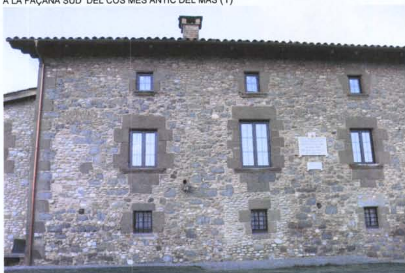
PARAMENT DE LA CARA EST , COS (1) CONSTRUÏT AMB CÒDOLS DE RIU.
