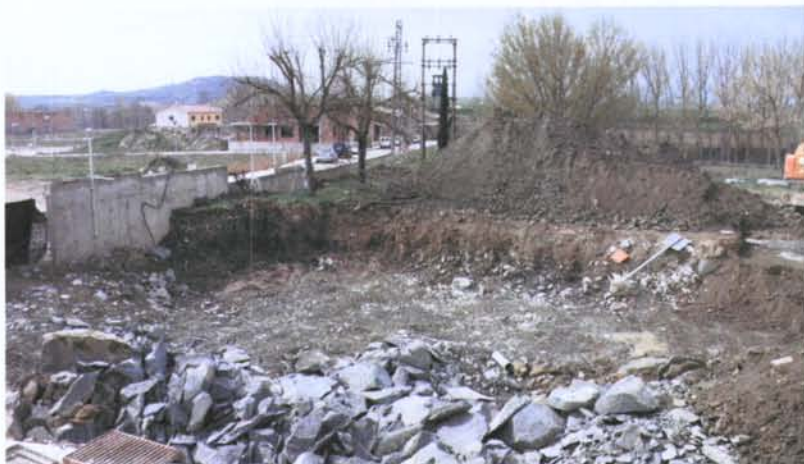
TREBALLS DE REBAIX. LA ROCA AFLORA A POCA PROFUNDITAT
