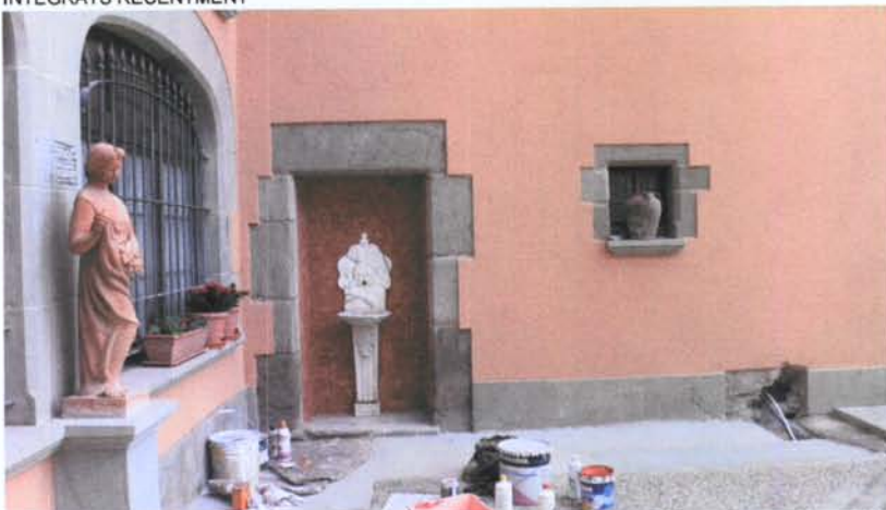
DETALL D'UNA FONT INTEGRADA EN UNA DE LES PORTES TAPIADES. FAÇANA OEST, COS (1)
