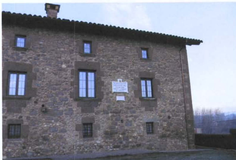
VISTA DE TOTA LA CARA EST, COS (1). DETALL DE LES TRES PLANTES AMB FINESTRES SIMPLS.
