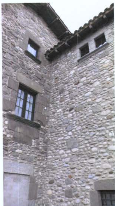
DETALL DEL COS ANNEX AL NORD , ADOSSAT A L'ANTIC PARAMENT DEL COS (1)
