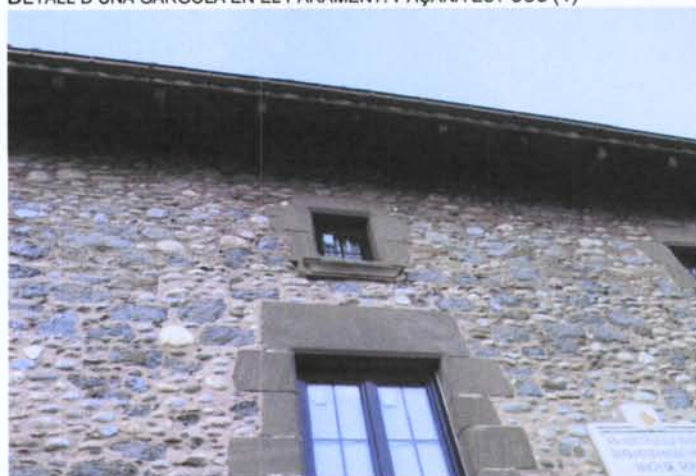
DETALL DE LES FINESTRES SUPERIORS AMB ELS BRANCALS I AMPITS
