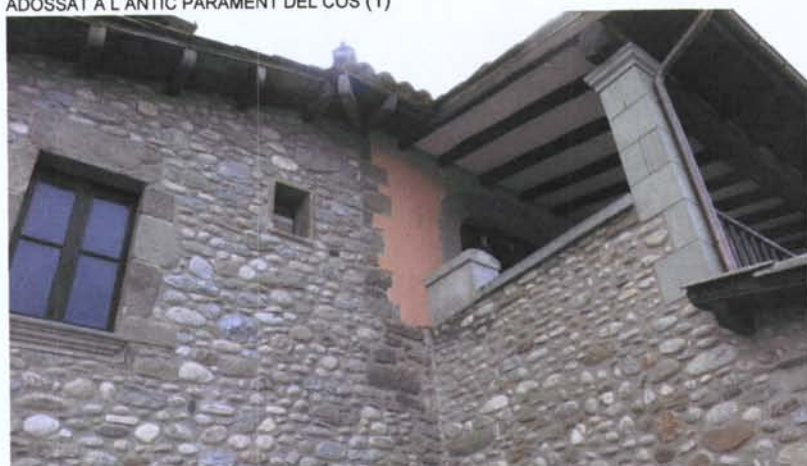
DETALL DEL COS ANNEX AL NORD I DETALL DE L'ARESTA DEL LÍMIT POSSIBLE DEL MAS PRIMITIU.
