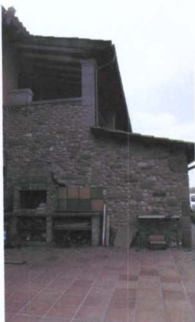
DETALL DE LA GALERIA DEL PRIMER PIS , COS (3). DETALL DEL COS DAVANTER PROBABLEMENT UN ANNEX EN ÈPOCA MODERNA.
